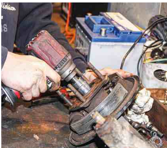
Mais il faut de la méthode et un outillage adapté pour déboulonner les différents éléments de l'embrayage (cylindre récepteur, cloche...), desserrer les vis qui maintiennent la boîte au moteur, etc.
