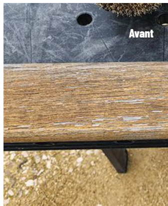
Cette main courante d'un garde-corps de fenêtre est recouverte d'une vieille lasure qui s'écaillait. Le Renovateur 7800 AA a permis de la décapier en quelques secondes.
