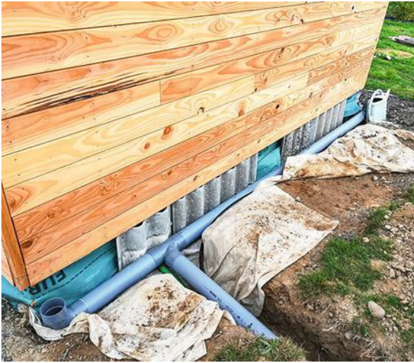
Dernières opérations : les évacuations d'eaux pluviales et la mise en place devant les pneus de plaques en Fibrociment récupérées : « Ils ont besoin d'être protégés des UV, sinon ils se dégradent. »
