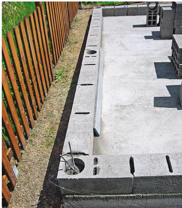
4 Deux personnes ne sont pas de trop pour étaler et tirer le béton avec une longue règle de maçon. Le soin apporté au calage du coffrage compte beaucoup pour cette opération.
