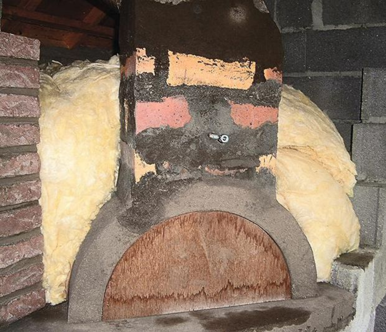
22 Pour renforcer l'isolation et garder plus longtemps la chaleur, on recouvre la voûte du fournil et la base du four de laine de roche, généreusement étalée.
