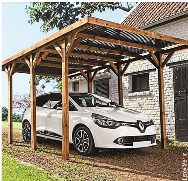
Carport pour une voiture, d'une surface utile de 13,30 m 2 . Sa structure en pin autoclavé comprend six poteaux avec contrefiches de 11,5 x 11,5 cm, qui supportent un toit plan légèrement incliné couvert de polycarbonate ondulé.
