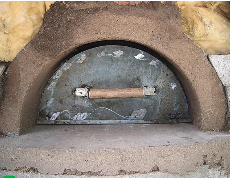
23 Une porte est indispensable pour garder la chaleur du four. Celle-ci est à double paroi, avec de la laine de roche entre les deux. Une réalisation « maison » qui épouse parfaitement le cintre.
