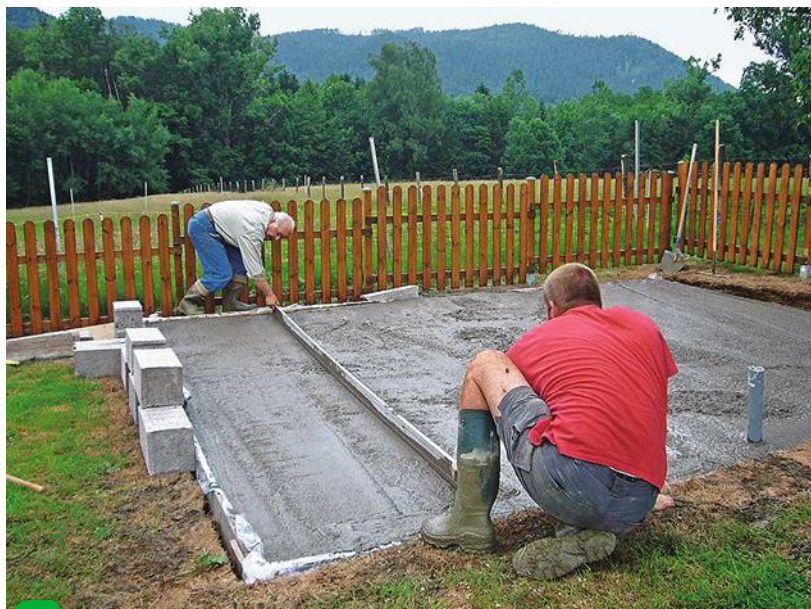
4 Deux personnes ne sont pas de trop pour étaler et tirer le béton avec une longue règle de maçon. Le soin apporté au calage du coffrage compte beaucoup pour cette opération.
