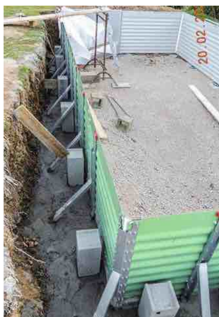
➡ Tous les mètres, des jambes de force métalliques maintiennent les parois. Pour soutenir la future plage, le couple a posé des parpaings à la verticale tout autour du bassin.
