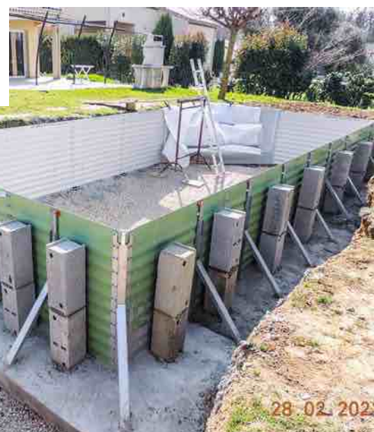
➡ Un deuxième rang de parpaings est collé au mortier sur les premiers. Le fond de la piscine sera également recouvert d'un radier.
