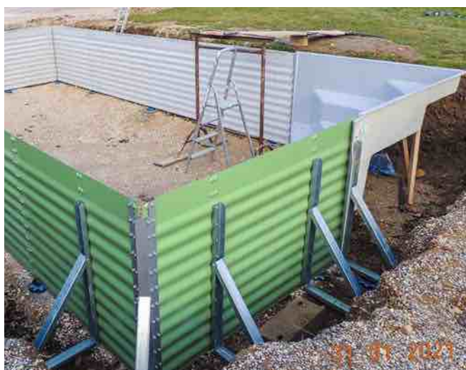
➡ L'escalier, un modèle « Square », forme l'angle de la piscine. C'est une pièce d'un seul tenant à assembler par boulonnage aux panneaux d'acier contigus. Un support en bois le maintient dans la bonne position.
