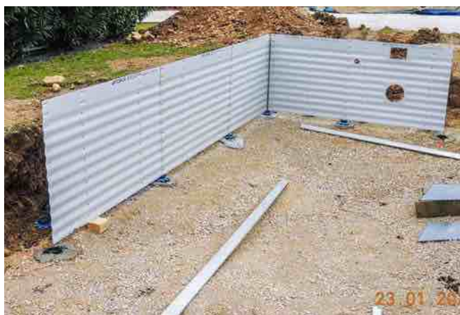
➡ Les panneaux qui forment le pourtour du bassin sont en acier ondulé d'une épaisseur de 165/100° de mm.
