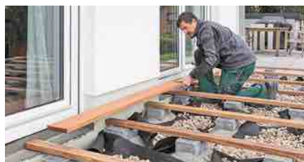
➡ ... SUR MOELLONS BÉTON P40
