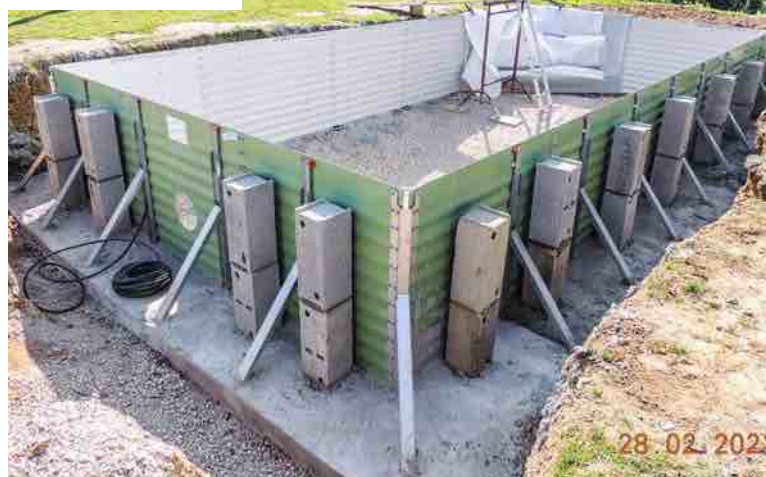
➡ Un deuxième rang de parpaings est collé au mortier sur les premiers. Le fond de la piscine sera également recouvert d'un radier.
