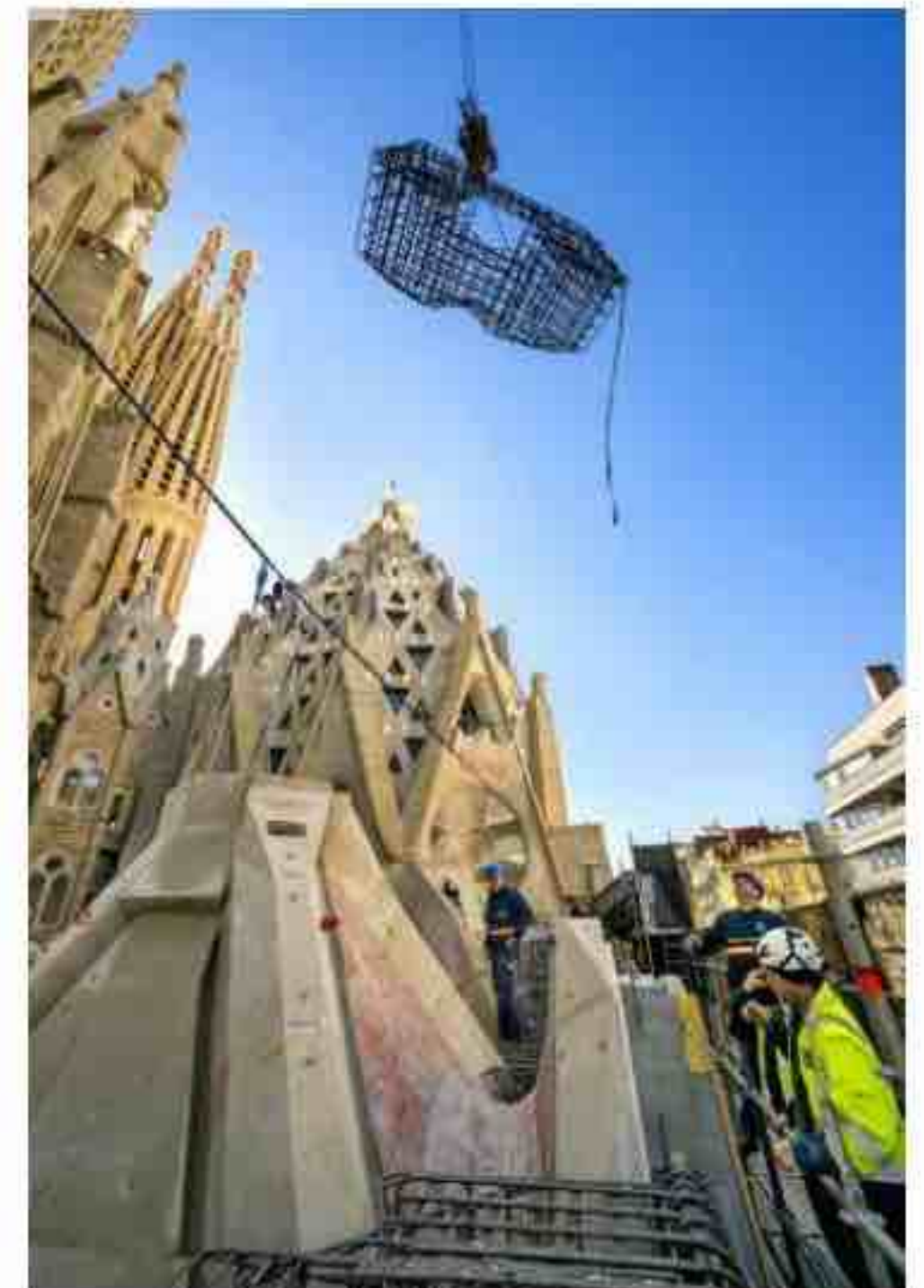
Côté nord (façade de l'abside), les ouvriers posent un ferrailage qui servira d'ossature à une forme en béton armé.
