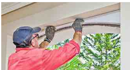
➔ POSER UNE PORTE-FENÊTRE ISOLANTE P 26
