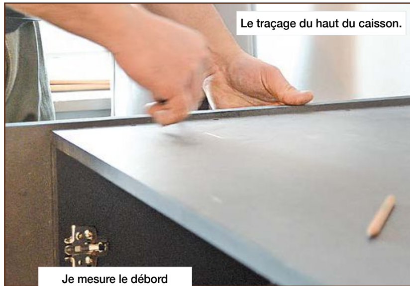
Je suis le profil de mes plinthes avec le compas pour tracer sur la joue.
