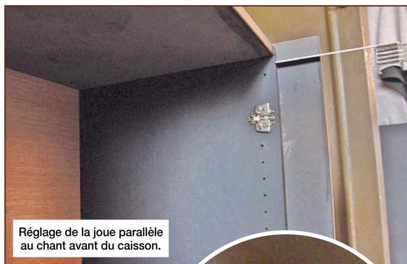
Les cales permettent de régler la joue.
