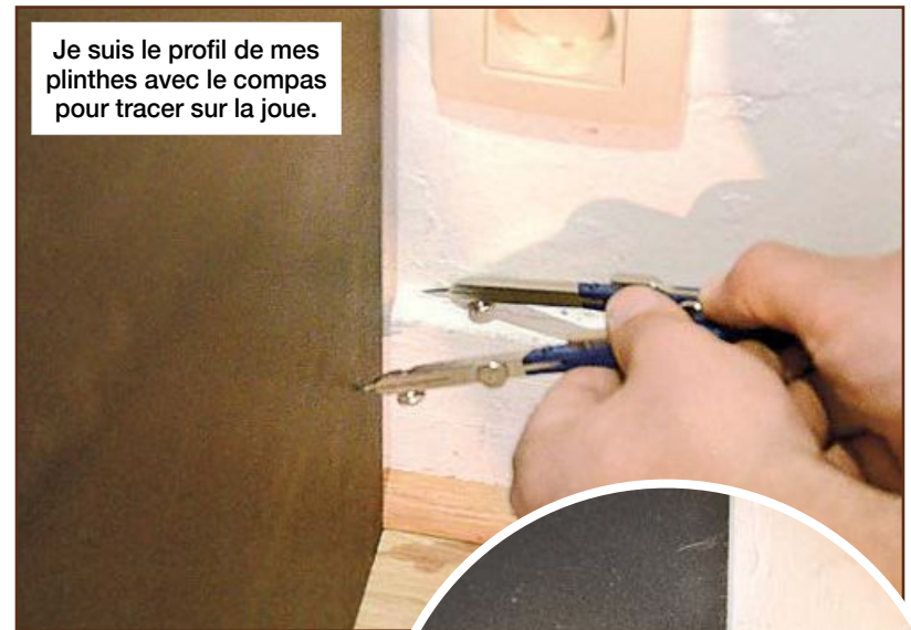
Le traçage du haut du caisson.
