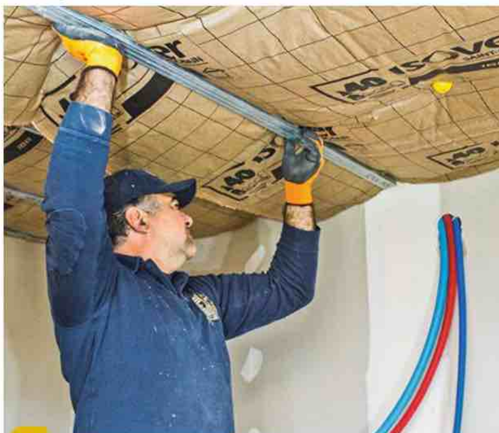
11 Clipsez les fourrures métalliques sur les capuchons. Si nécessaire, utilisez des éclisses afin de rallonger les fourrures.
