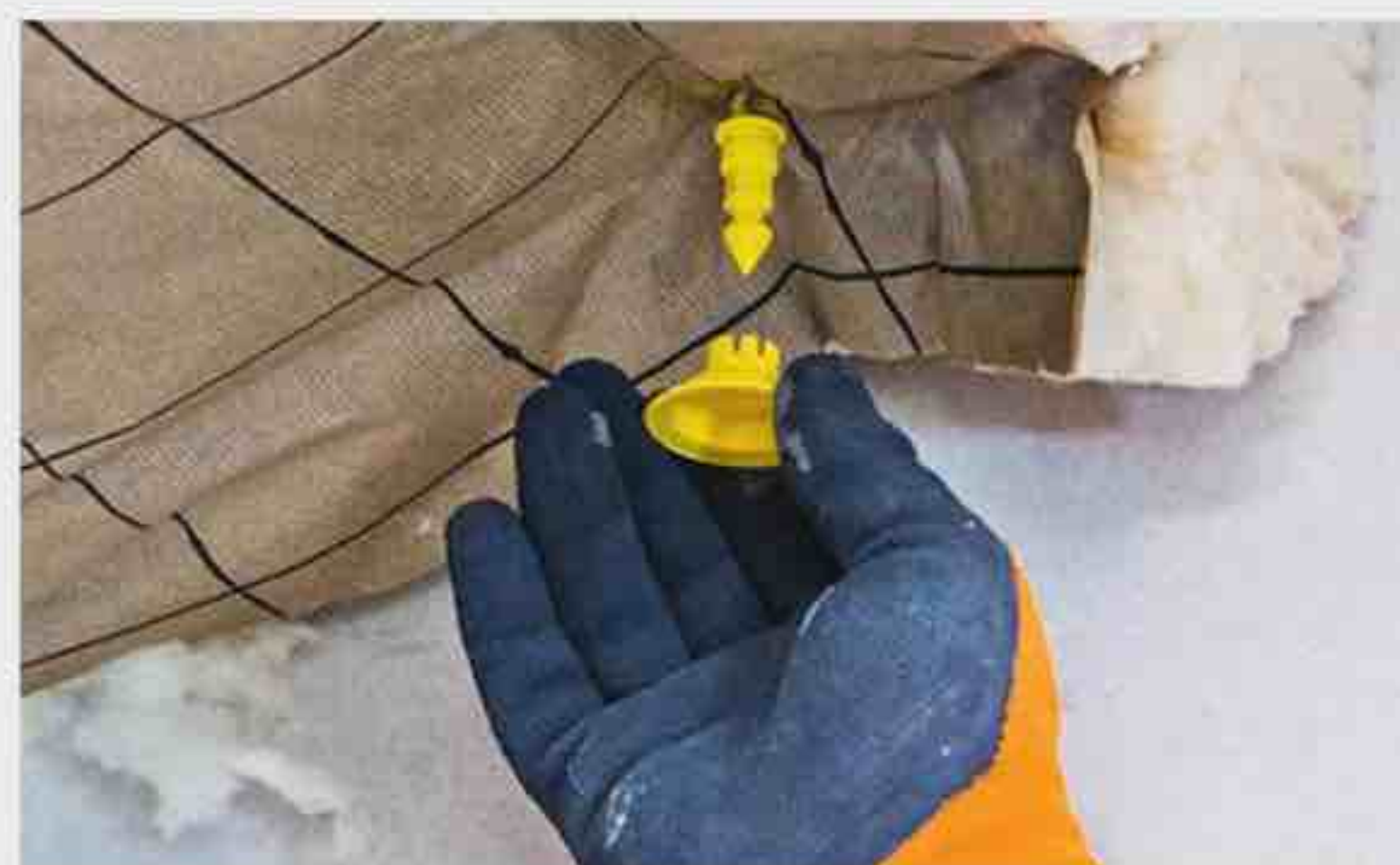
10 Ajoutez une rondelle pour maintenir la laine de verre de façon bien tendue. Utilisez un maillet en caoutchouc pour clipser les capuchons sur les têtes des suspentes. Insérez la rondelle qui permet de fixer la laine de verre sur la suspen- te, puis verrouillez à l'aide du capuchon. Utilisez un maillet en caoutchouc. Répétez l'opération pour les suspentes suivantes.
