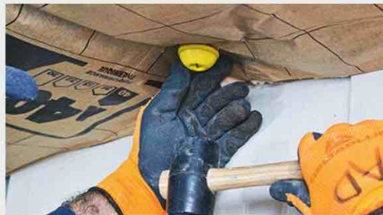
10 Ajoutez une rondelle pour maintenir la laine de verre de façon bien tendue. Utilisez un maillet en caoutchouc pour clipser les capuchons sur les têtes des suspentes. Insérez la rondelle qui permet de fixer la laine de verre sur la suspen- te, puis verrouillez à l'aide du capuchon. Utilisez un maillet en caoutchouc. Répétez l'opération pour les suspentes suivantes.
