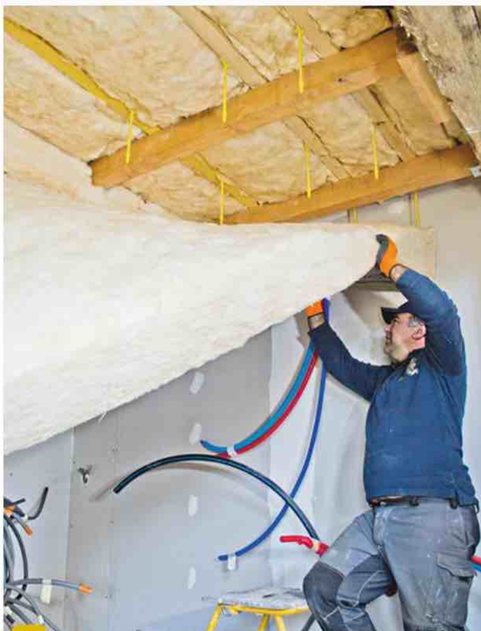
9 Déroulez puis embrochez sur les suspentes la seconde couche de laine (ép. : 30 cm) revêtue d'un pare-vapeur en papier kraft. La surface étant importante, faites-vous aider.
