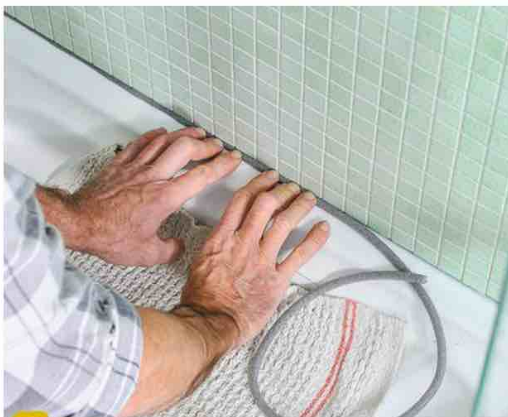
18 Au bas de la paroi latérale, seul le joint est à refaire. L'intervalle à combler est trop large pour le mastic seul : comprenez du fond de joint en mousse dans l'interstice.
