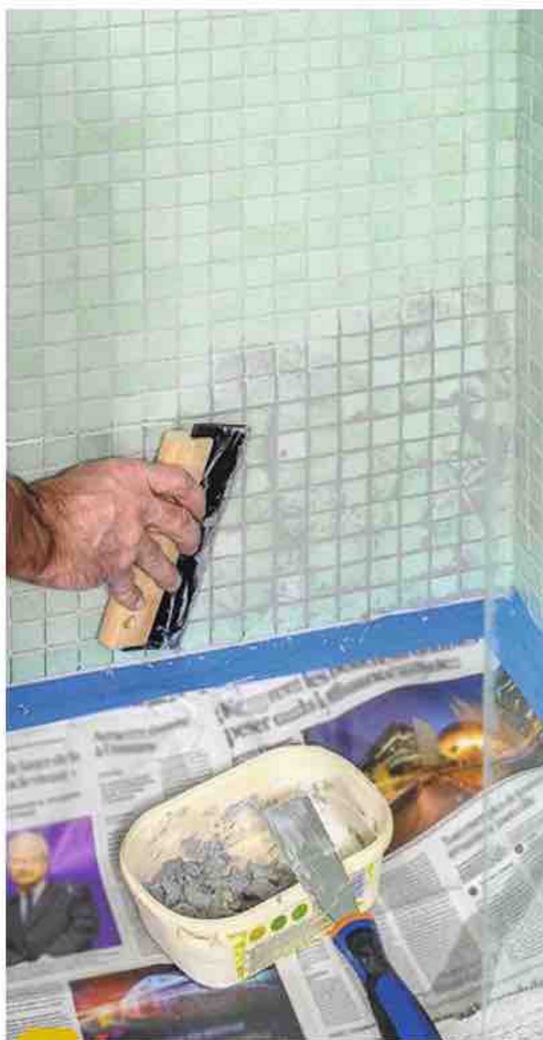
20 Après séchage du mastic, appliquez le joint de la mosaïque. Faites-le pénétrer à l'aide d'une raclette en caoutchouc. Puis essuyez le surplus à l'éponge humide.
