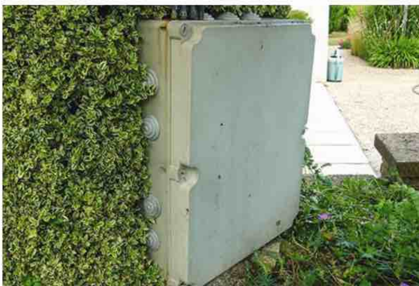
Derrière un fusain du Japon, le coffret électrique alimente la pompe de reprise, une électrovanne branchée sur le surpresseur de la réserve d'eaux pluviales, le filtre UV et les éclairages de jardin.
