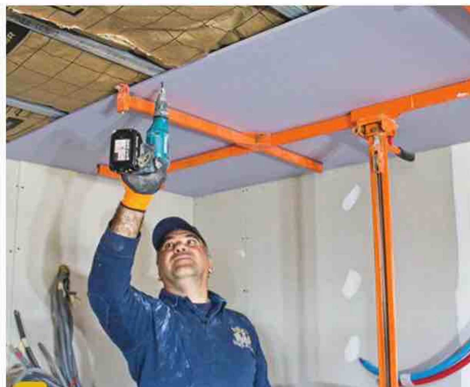
12 À l'aide d'un lève-plaque, positionnez une plaque. Commencez dans un angle. Placez-la contre les fourrures, puis fixez-la à raison d'une vis tous les 20 cm environ.
