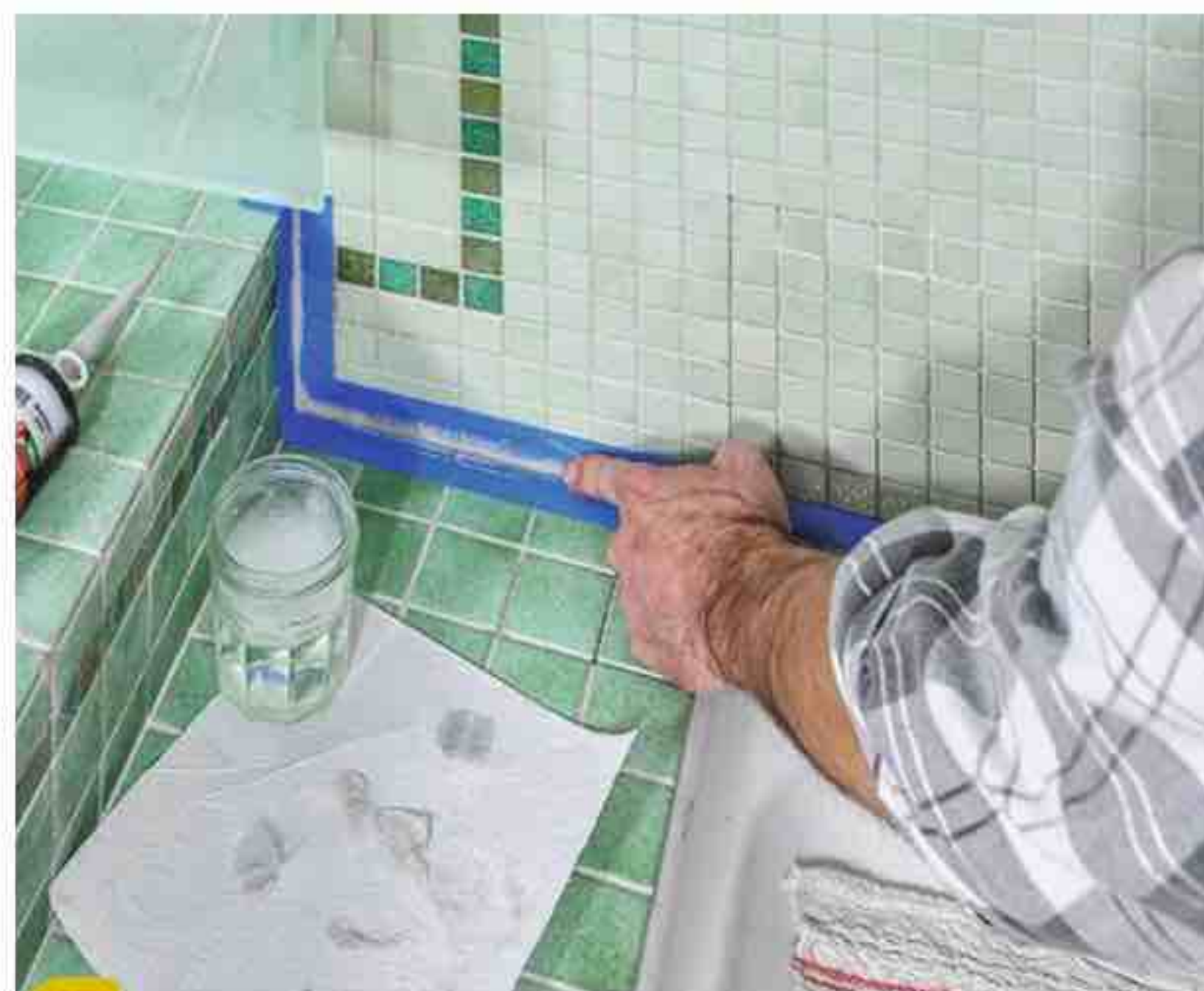
19 Après séchage de la colle à carrelage, déposez une bande d'adhésif de part et d'autre du joint à réaliser. Appliquez et lissez le mastic, retirez ensuite l'adhésif.
