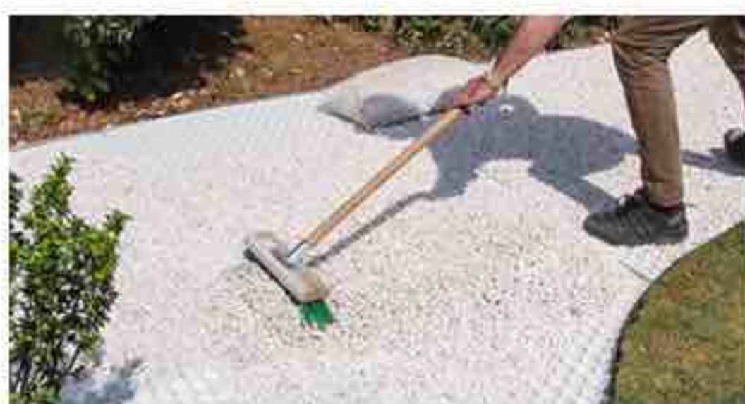
➡ Allée en gravier stabilisé P 24
