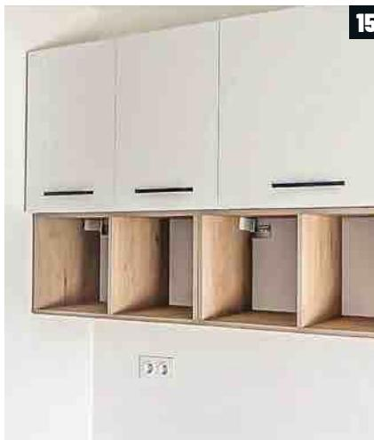
Les poignées de portes et tiroirs sont vissées par l'intérieur. Des cubes de rangement ont également été fixés sous les meubles haut. Les plaques peuvent être posées sur les prises et interrupteurs.
