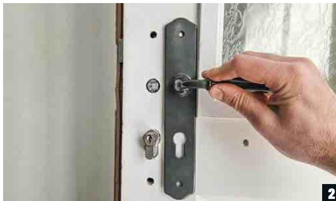
Comparez les dimensions prises avec celles de la nouvelle poignée. Vous aurez ainsi la possibilité de la faire changer au besoin avant d'aller plus loin dans l'installation.
