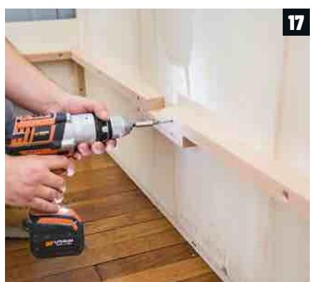
Le sommier doit être soutenu sur ses quatre côtés et au milieu. Deux autres supports sont donc nécessaires en tête et en bout. Ils se composent de trois tasseaux, positionnés de façon à former une encoche d'encastrement destinée à une barre centrale.
