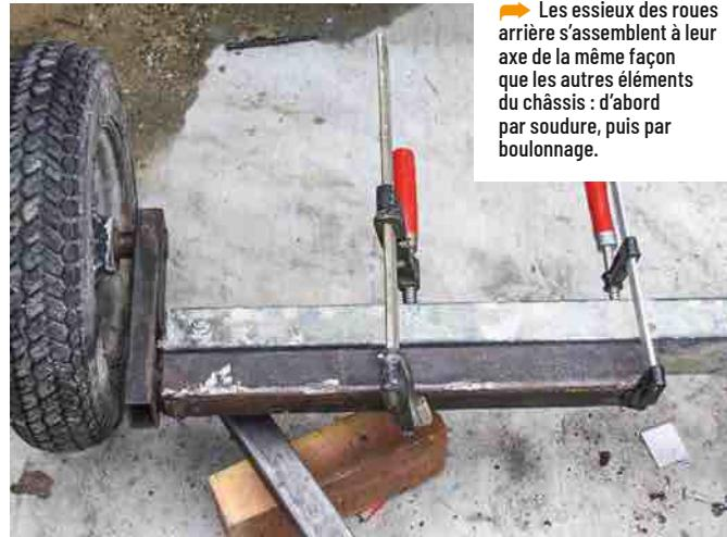
Les essieux des roues arrière s'assemblent à leur axe de la même façon que les autres éléments du châssis : d'abord par soudure, puis par boulonnage.
