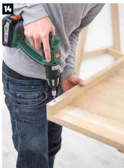
→ Débitez les deux tasseaux de renfort, de 46 x 25 mm de section, à une longueur de 60 cm. Percez-y sur chant, de part en part, trois à quatre trous fraisés de Ø 4 mm. Puis fixez-les en sous-face du plateau, bien bord à bord, par collage et vis de Ø 5 x 60 mm.
