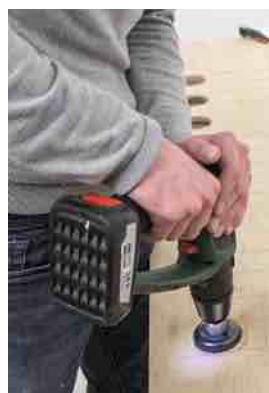
➤ À l'intersection de chaque axe, un rang sur deux, percez à la scie cloche le haut et le bas des espacements entre barreaux.
