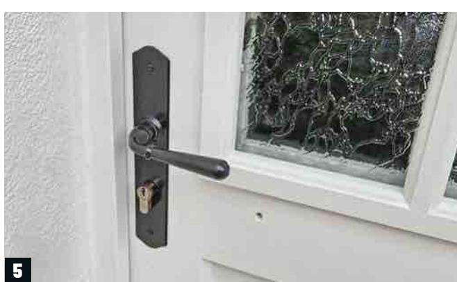
Votre nouvelle poignée est en place, pensez à tester l'ouverture et la fermeture de la porte, tout doit être fluide, sans jeu ni blocage.
