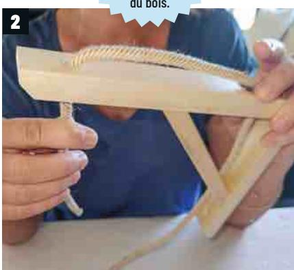
→ Coupez le câble à 50 cm du bas de l'équerre. Dénudez les deux brins et raccordez-les à l'interrupteur. Dénudez l'extrémité et connectez les fils à la fiche mâle. Procédez de même pour la seconde lampe.
