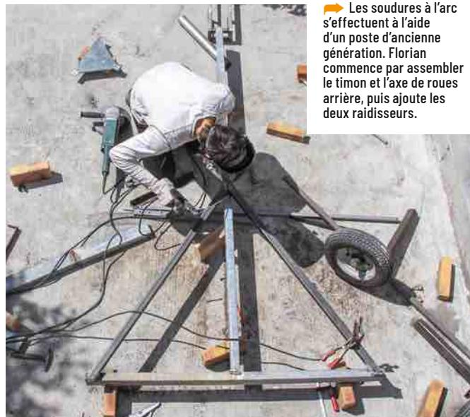
► Les soudures à l'arc s'effectuent à l'aide d'un poste d'ancienne génération. Florian commence par assembler le timon et l'axe de roues arrière, puis ajoute les deux raidisseurs.
