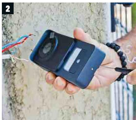
Dévissez le capot de protection de la nouvelle platine de rue avec le tournevis fourni. Retirez le cache central donnant accès aux câbles et présentez la platine au mur.
