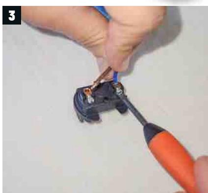
→ Démontez la douille. Glissez les éléments du serre-câbles, le cache en bois, la vis et le cache de la douille sur le câble. Dénudez ce dernier et raccordez les fils neutre et phase aux connecteurs de la douille. Fermez et vissez le tout.
