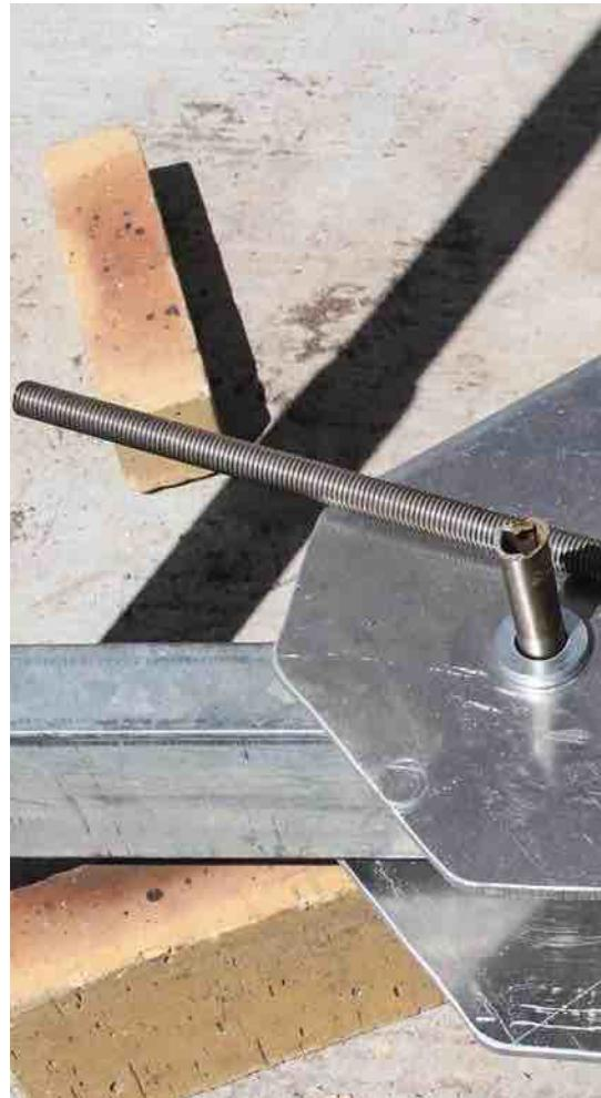
► La liaison à renforcer est prise en sandwich entre les goussets en tôle d'alu. Ils s'y fixent au moyen de vis à métaux autoforeuses, serrées avec une clé à œillet.
