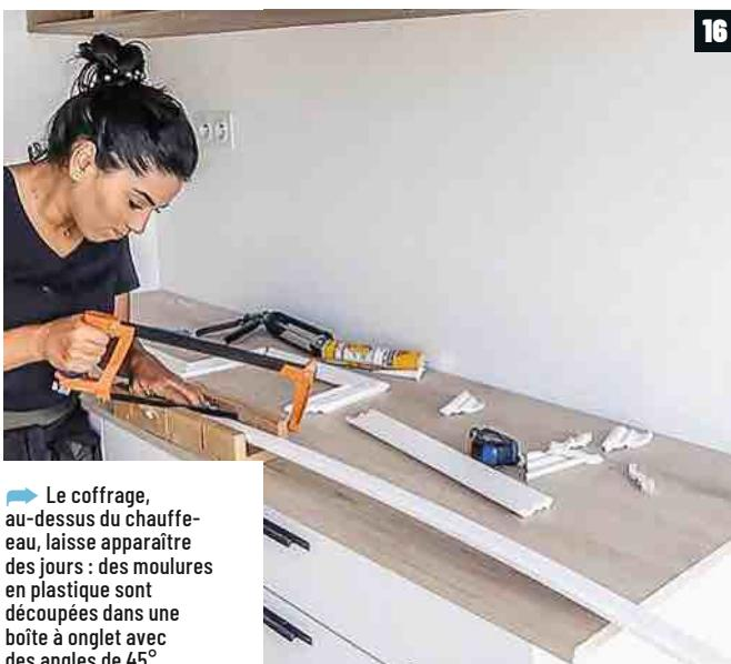
Le coffrage, au-dessus du chauffe-eau, laisse apparaître des jours : des moulures en plastique sont découpées dans une boîte à onglet avec des angles de 45°.
