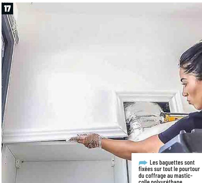
Les baguettes sont fixées sur tout le pourtour du coffrage au mastic-colle polyuréthane.
