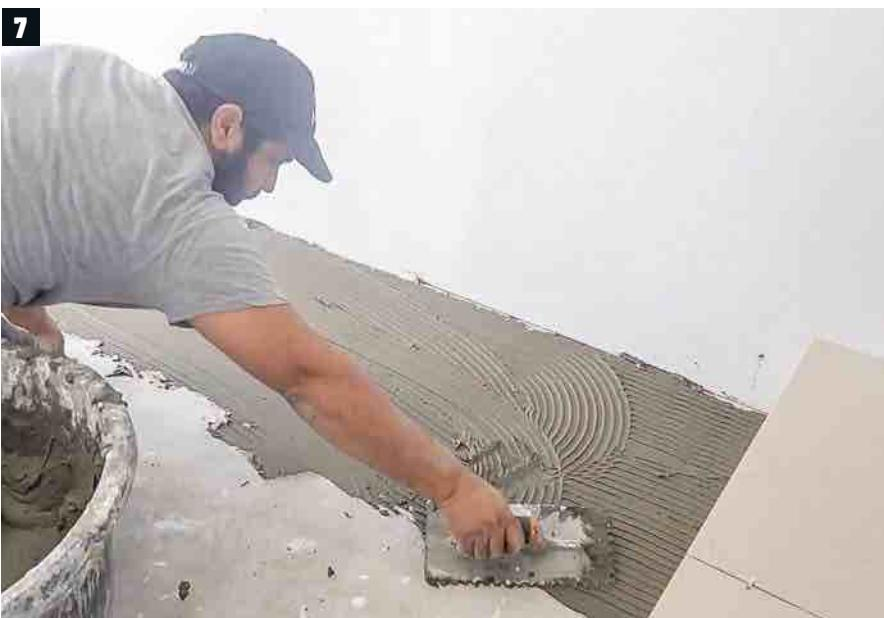
→ Le sol étant bien plan, il n'a pas été nécessaire de réaliser un râgrégation. La colle est directement étalée au sol par section d'1 m<sup>2</sup>, au peigne à carrelage. Au fil de l'avancée, les croisillons sont insérés entre les carreaux pour ménager l'espace nécessaire aux joints. Les carreaux sont tapotés au maillet caoutchouc pour assurer le collage.
