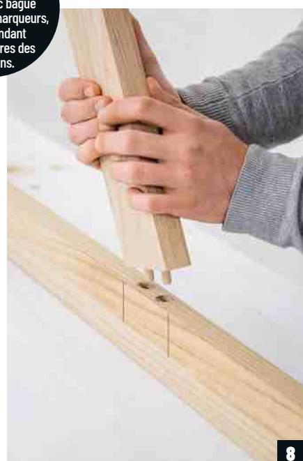
Percez à la profondeur requise et répétez la procédure pour les autres liaisons des montants. Ensuite, avec les tourillons placés à sec, faites un assemblage « à blanc » afin de vous assurer du bon emboîtement des éléments. Procédez de même depuis l'étape 5 pour l'assemblage du sommet.
