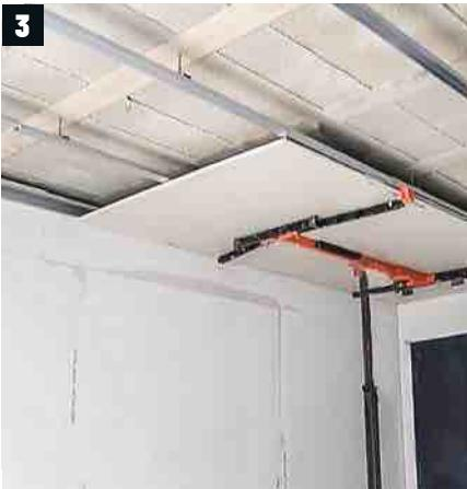
→ Une paroi sur rails métalliques crée une séparation avec le chauffe-eau qui est coffré pour dissimuler les gaines. Les bandes à joint sont enduites sur toutes les plaques aux murs et au plafond.
