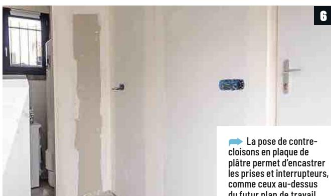
→ La pose de contre-cloisons en plaque de plâtre permet d'encastrer les prises et interrupteurs, comme ceux au-dessus du futur plan de travail.
