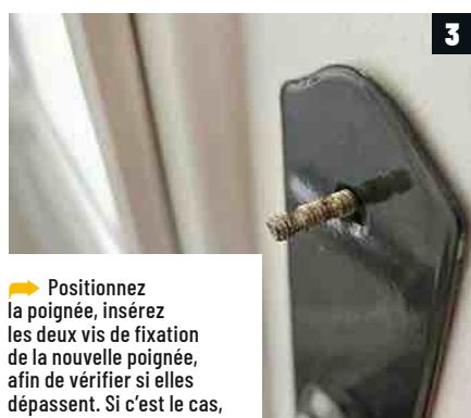
Positionnez la poignée, insérez les deux vis de fixation de la nouvelle poignée, afin de vérifier si elles dépassent. Si c'est le cas, mesurez la partie à couper.
