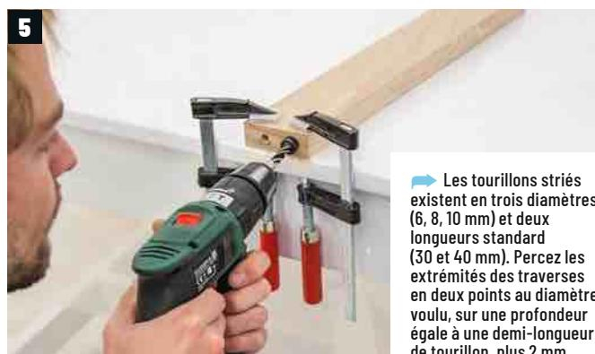
Les tourillons striés existent en trois diamètres (6, 8, 10 mm) et deux longueurs standard (30 et 40 mm). Percez les extrémités des traverses en deux points au diamètre voulu, sur une profondeur égale à une demi-longueur de tourillon, plus 2 mm.
