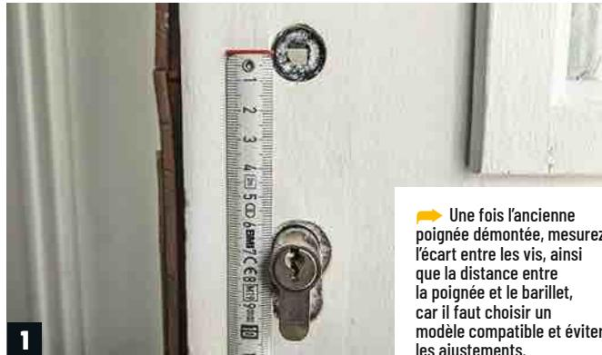
Une fois l'ancienne poignée démontée, mesurez l'écart entre les vis, ainsi que la distance entre la poignée et le barillet, car il faut choisir un modèle compatible et éviter les ajustements.
