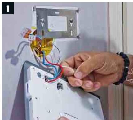
2 La sortie des câbles étant trop basse, faites une fine saignée dans l'enduit mural au burin pour le faire remonter jusqu'à l'orifice du socle de la platine de rue.
