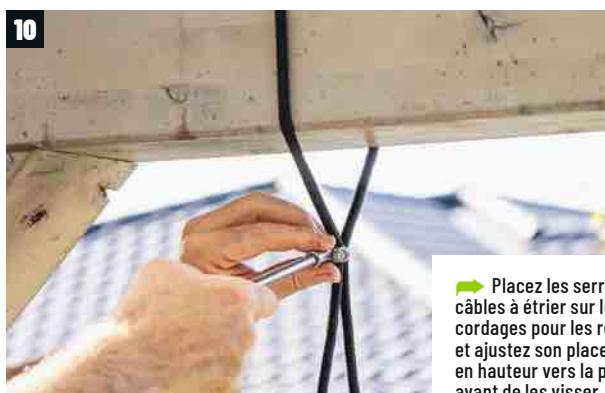
▶ Placez les serre-câbles à étrier sur les cordages pour les réunir et ajustez son placement en hauteur vers la poutre avant de les visser.
