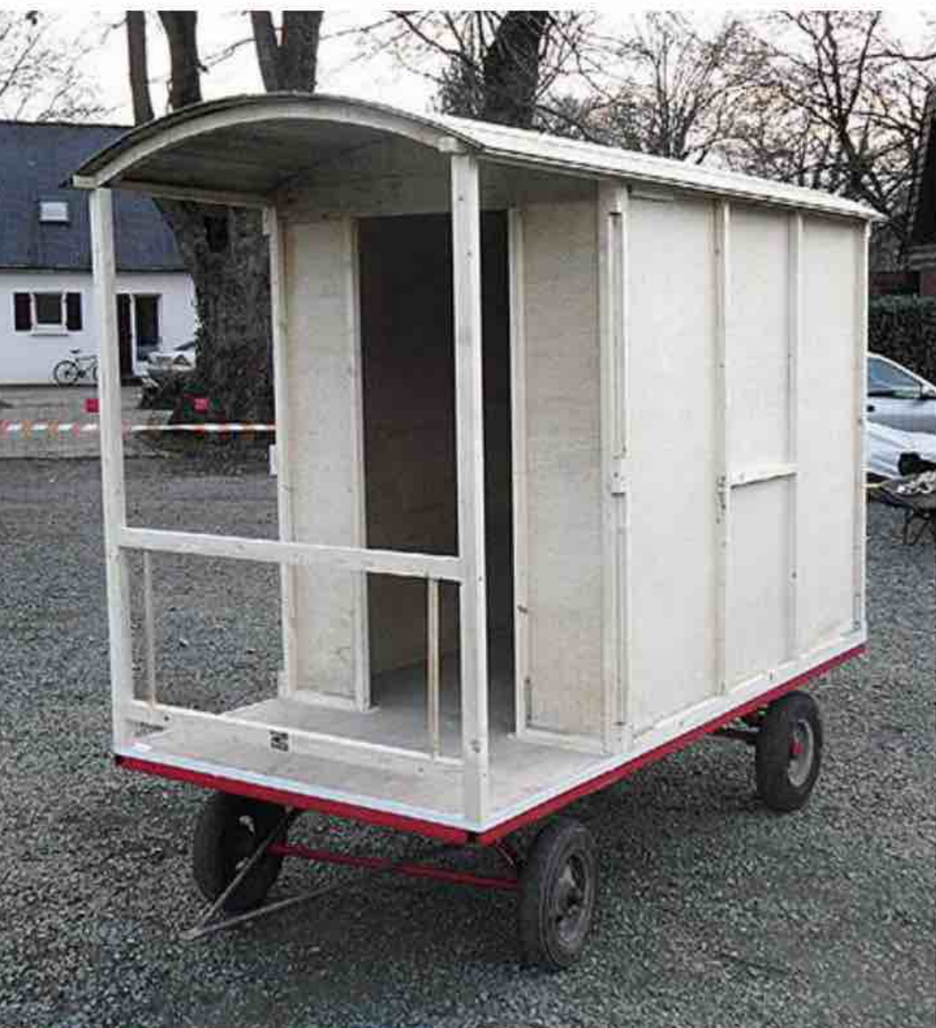
5. Les panneaux de contreventement, en contreplaqué de 5 mm, sont vissés de l'intérieur aux montants d'ossature. Celle-ci est revêtue d'un bardage cloué. L'isolation est réalisée avec des panneaux de polystyrène expansé (ép. 3 cm) pris en sandwich entre les deux revêtements.
