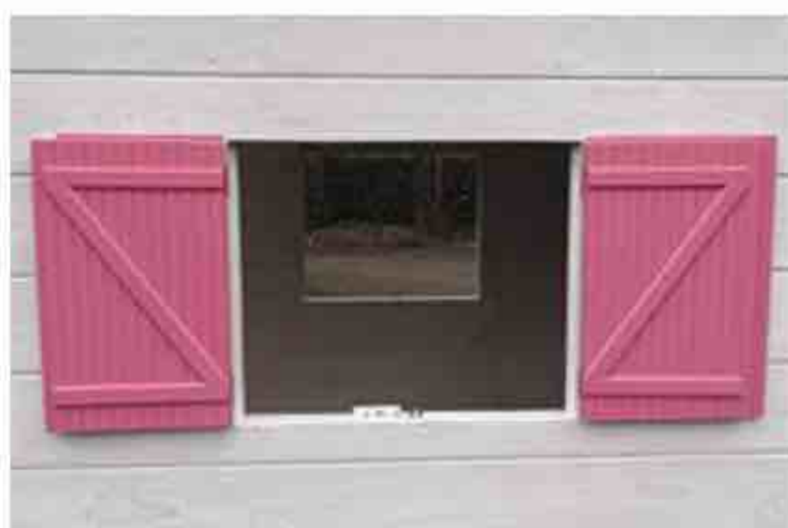
6. Le cadre de fenêtre mesure H. 40 x l. 49 cm. Il est garni d'une plaque de plexiglas de 5 mm d'épaisseur, montée sur une glissière insérée dans la cloison.
