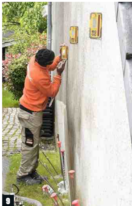
➔ Des cellules spéciales sont posées sur les façades au droit des tubes. Communicant en wifi avec le niveau laser, elles servent à contrôler l'injection en temps réel ainsi que le comportement global du bâtiment.
