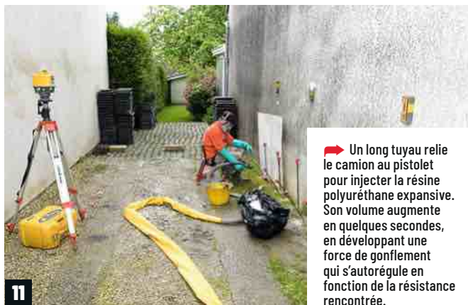
➔ Des cellules spéciales sont posées sur les façades au droit des tubes. Communicant en wifi avec le niveau laser, elles servent à contrôler l'injection en temps réel ainsi que le comportement global du bâtiment.
