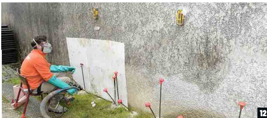
➔ Le technicien surveille les effets de chaque injection sur l'écran de la cellule correspondante. Grâce à un panneau amovible glissé entre les tubes et la façade, il protège cette dernière de toute projection éventuelle.
