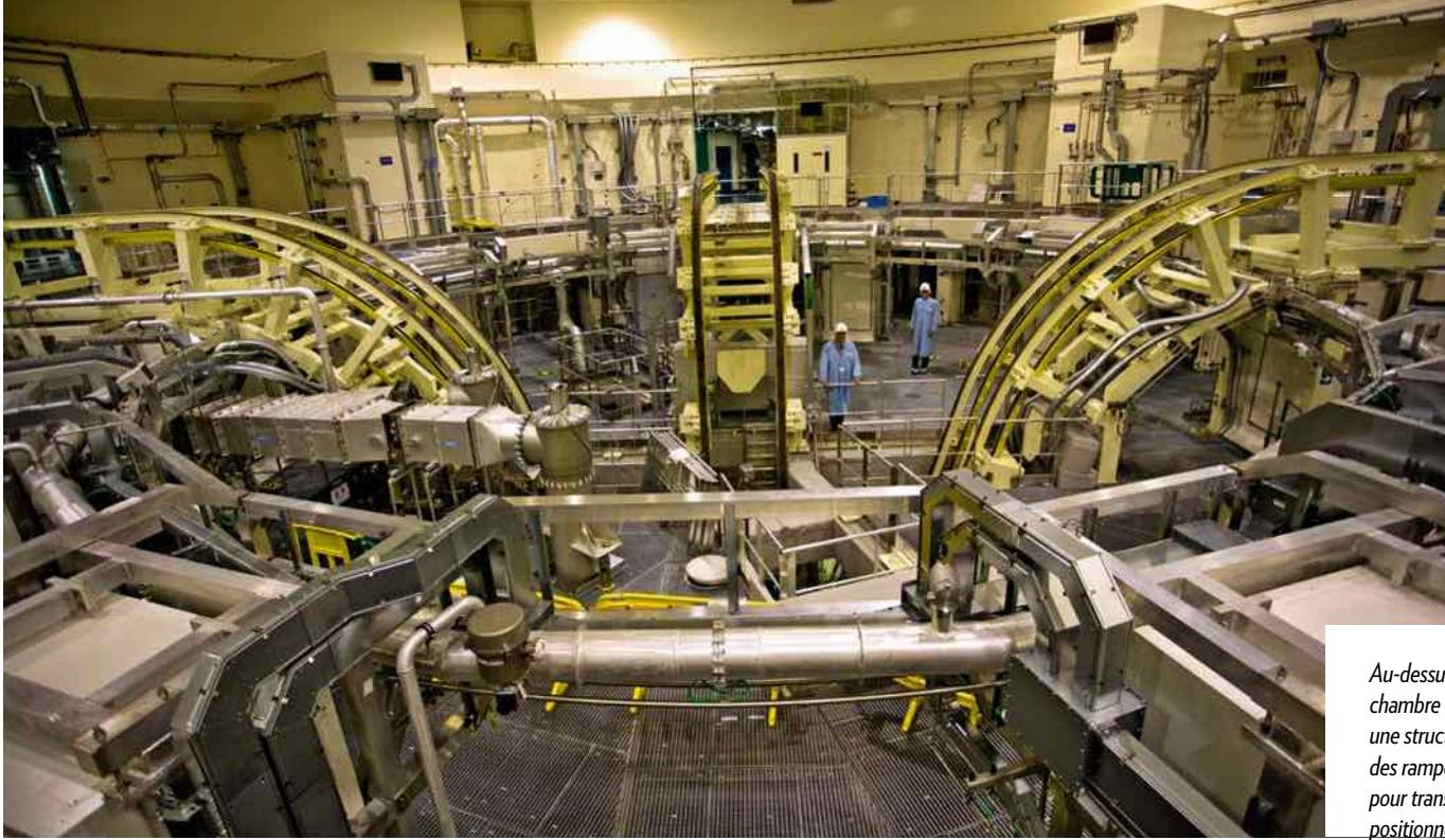
*Au-dessus de la chambre d'expériences, une structure avec des rampes articulées pour transporter et positionner le matériel.*
